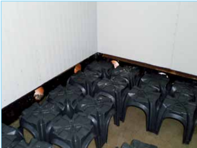
fig. 21) DZIATOSZYN – Polonia • ANITA Refrigerated Warehouse 5450 m 2
